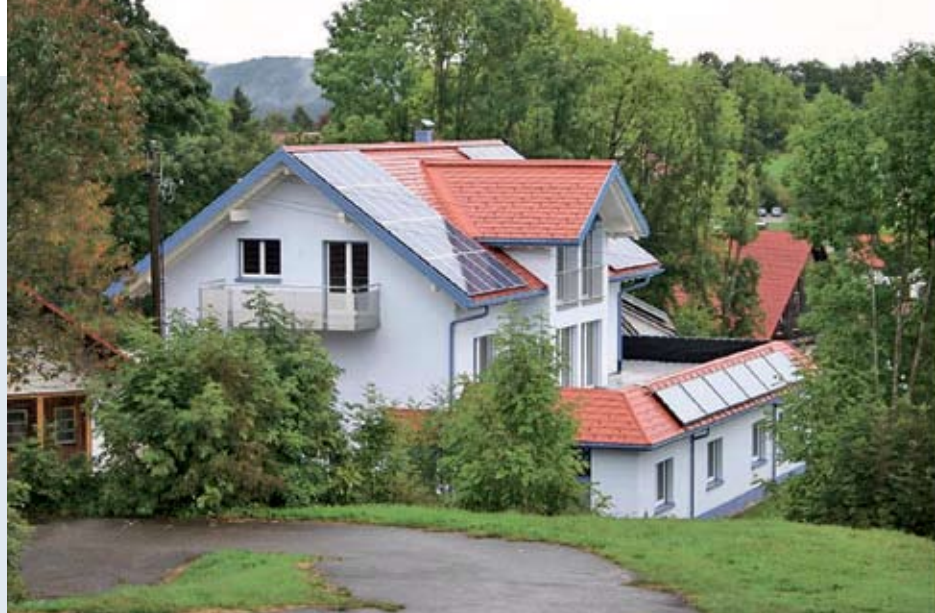
Klimaregelung, Brandschutz, Einbruchsicherheit – kaum etwas, das dieses Haus nicht kann.
